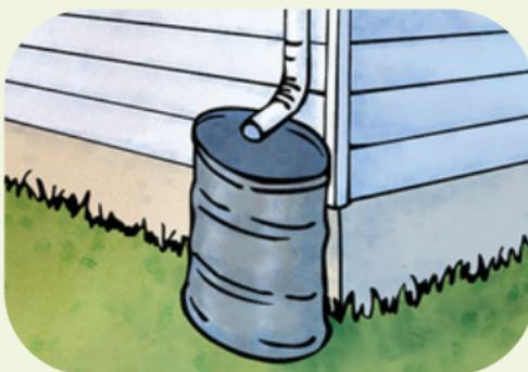
L'eau captée par les barils de pluie a plusieurs utilités. Pour être efficace, le baril doit être vidé entre les pluies
