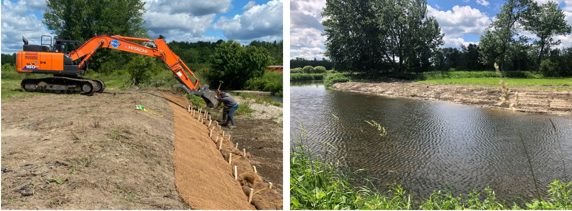
Figure 2 – Stabilisation des berges à la ferme Nouveau Ranch en 2021 ( Club conseil Gestrie-Sol, 2021 )
